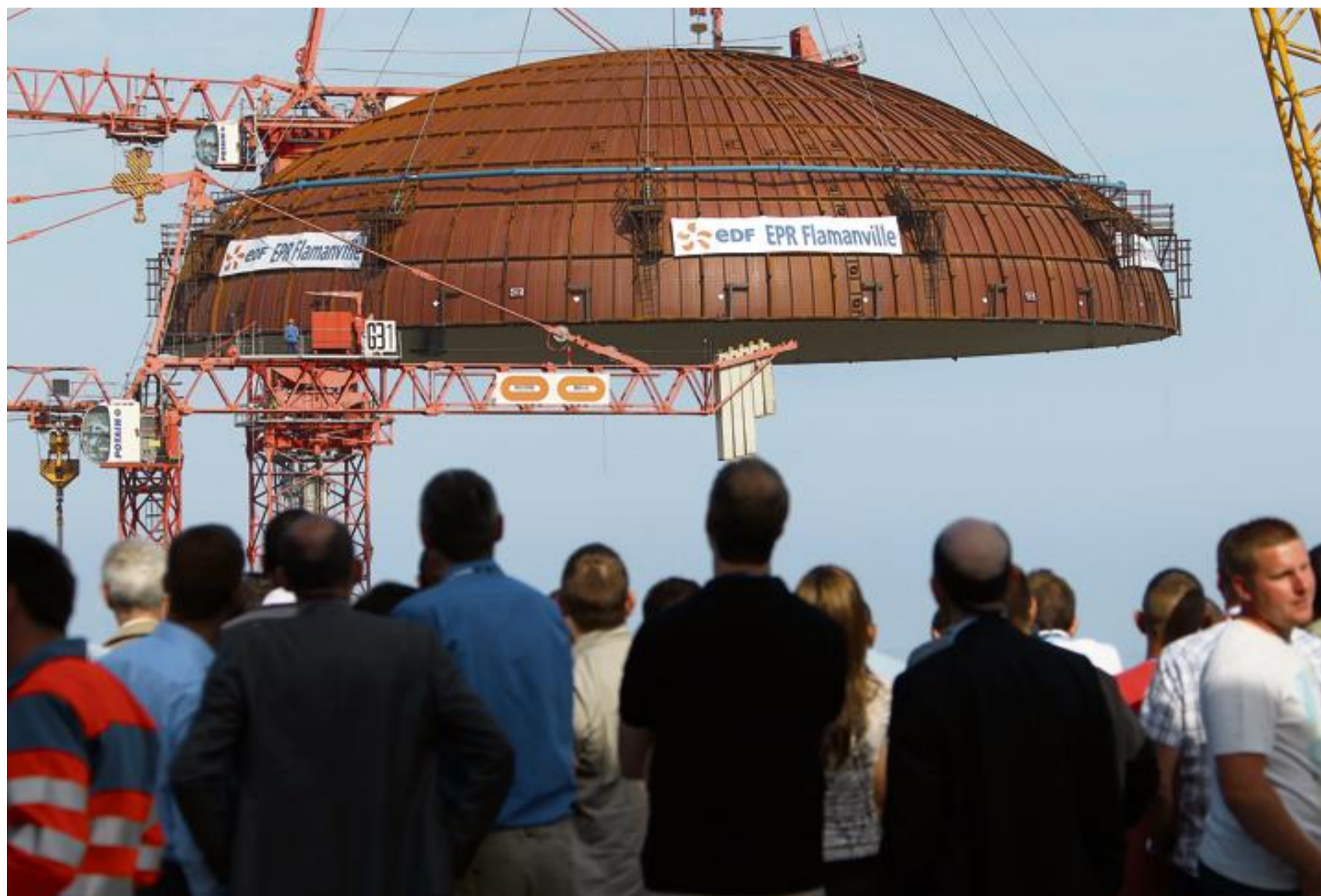
L'installation du dôme de l'EPR de Flamanville, le 16 juillet 2013.
